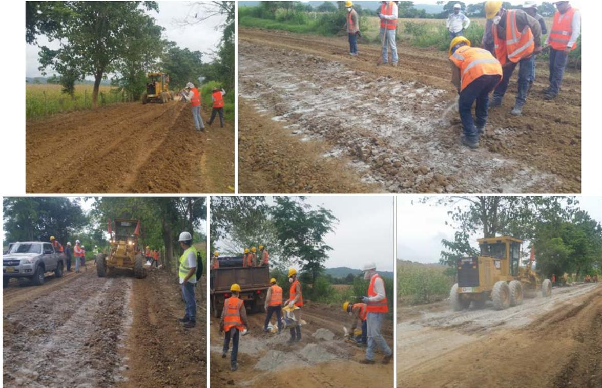
**Imagen 50. Proceso constructivo del tramo de prueba de la empresa PowerCem Colombia S.A.S.**
