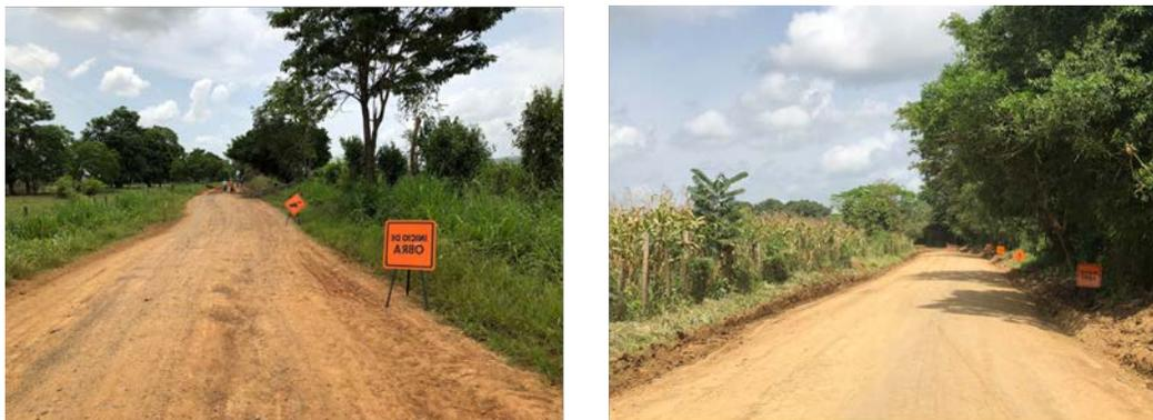
**Imagen 42. Tramo estabilizado con Multienzimas Orgánicas de la empresa INGTECO S.A.S**
