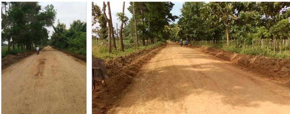
**Imagen 46. Tramo estabilizado con LTX1 de la empresa LA TIGRA MINING.**
