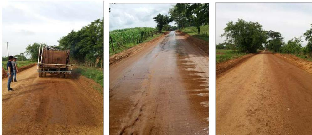
**Imagen 37. Aplicación del sello Dust Stop de la empresa ROADCORP S.A.S.**
