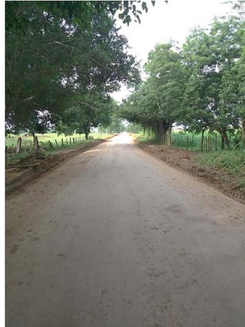
**Imagen 38.** Tramo estabilizado con Earthzyme/Dust Stop de la empresa ROADCORP S.A.S.
