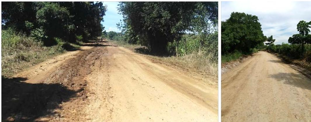
**Imagen 51. Tramo estabilizado con la Tecnología RoadCem de la empresa POWERCEM**
